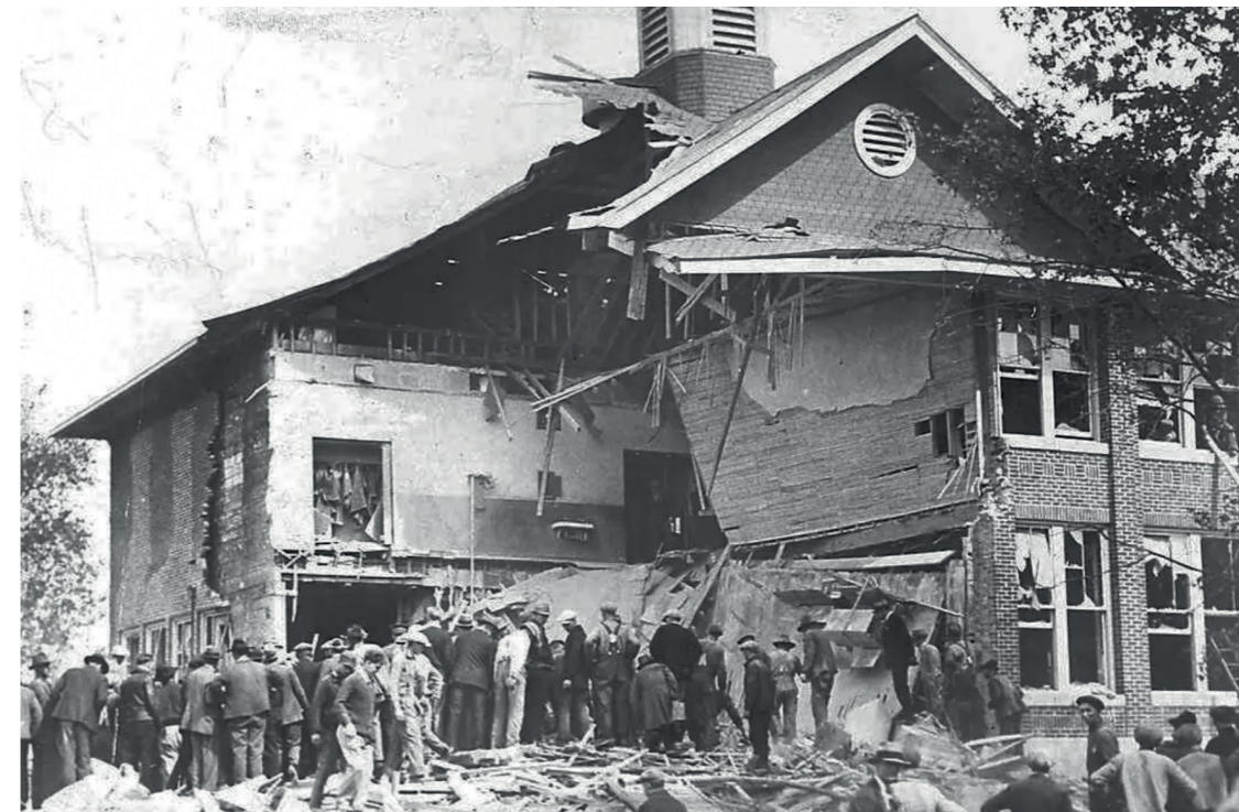
Рис. 2. Здание школы «Бат» после взрыва, 1927 г.
